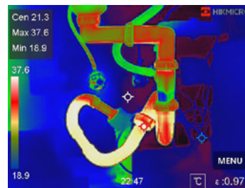
Tubagens de água quente
