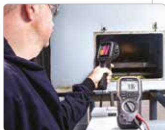
Anote automáticamente las imágenes térmicas con datos de carga críticos
