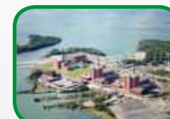
Planta Nuclear Olkiluoto 3 (Finlandia)
