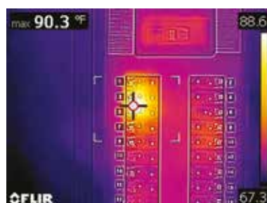
El cuadro de área con punto caliente muestra un fusible eléctrico activo
