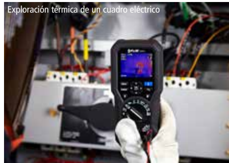
Exploración térmica de un cuadro eléctrico
