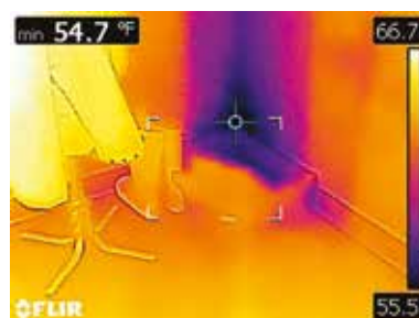
El cuadro de área con puntos fríos muestra la infiltración de aire
