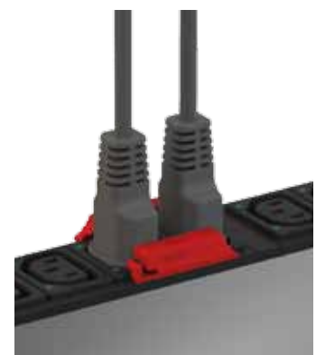
Bridas de enclavamiento
